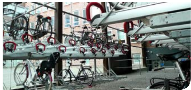
Abbildung 34: Zentrale Fahrradgarage in einem Verwaltungsgebäude
