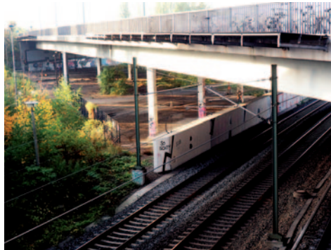
Bahnstrecke mit neuem Gleisbett (Foto: Tobias Fricke)
