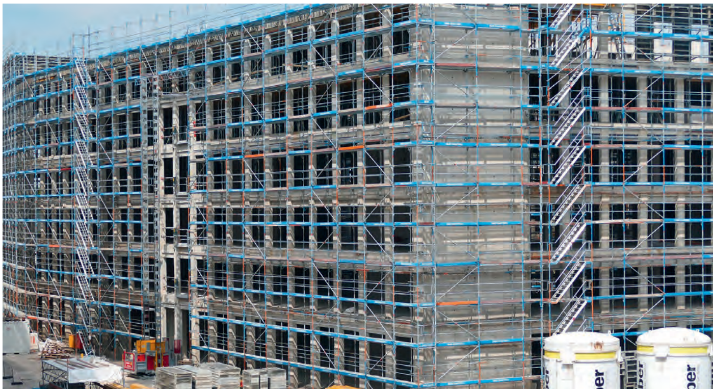
Baustelle in Köln (Foto: pixabay.com)
