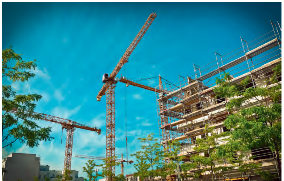
Baustelle in Düsseldorf (Foto: pixabay.com)
